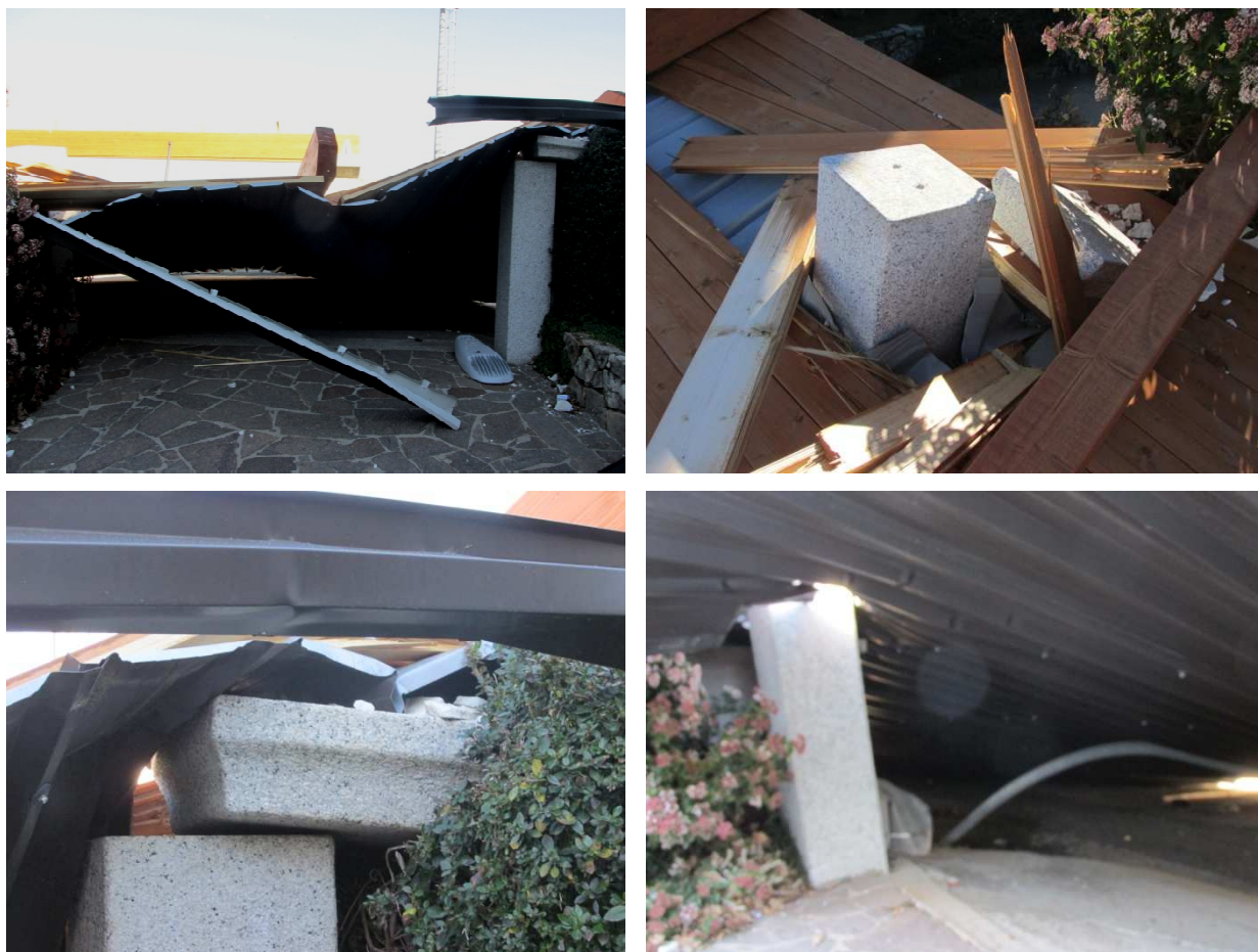
Figura 5. Ingresso carrabile - Danni alla recinzione
