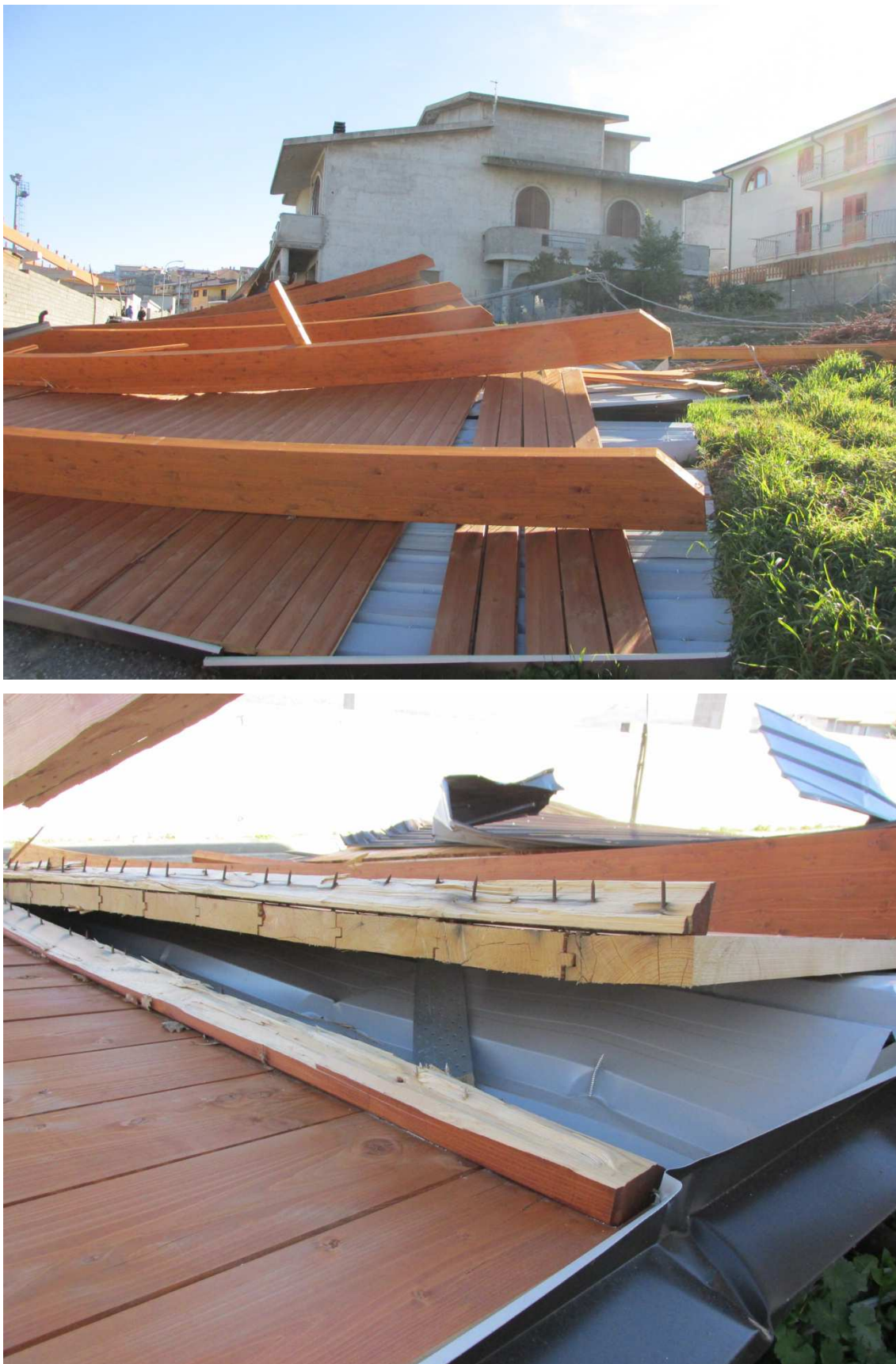
Figura 1. Orditura secondaria e tavolato di legno lungo la via XXV Aprile
