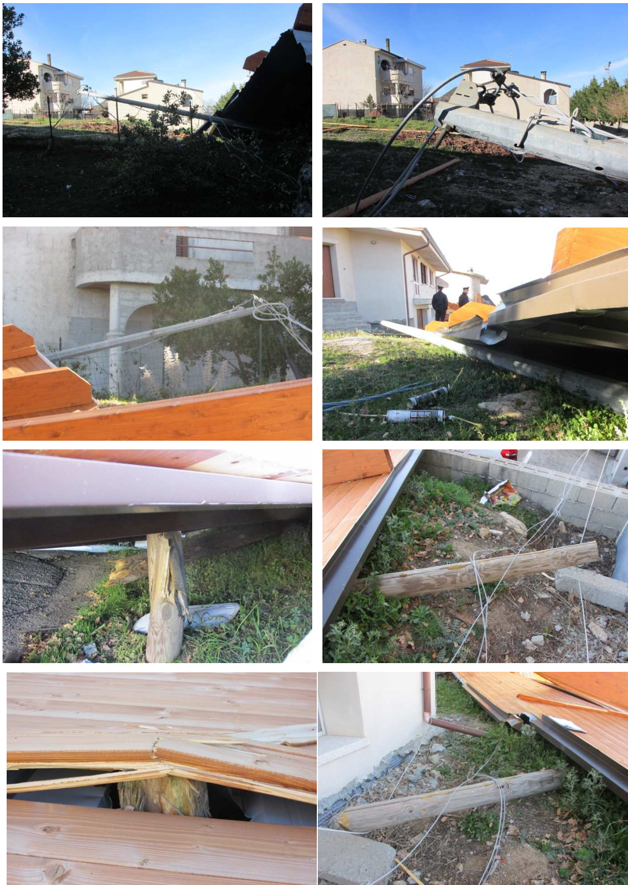
Figura 4 Pali linea elettrica (in alto) e palo linea telefonica (in basso) divelti.
